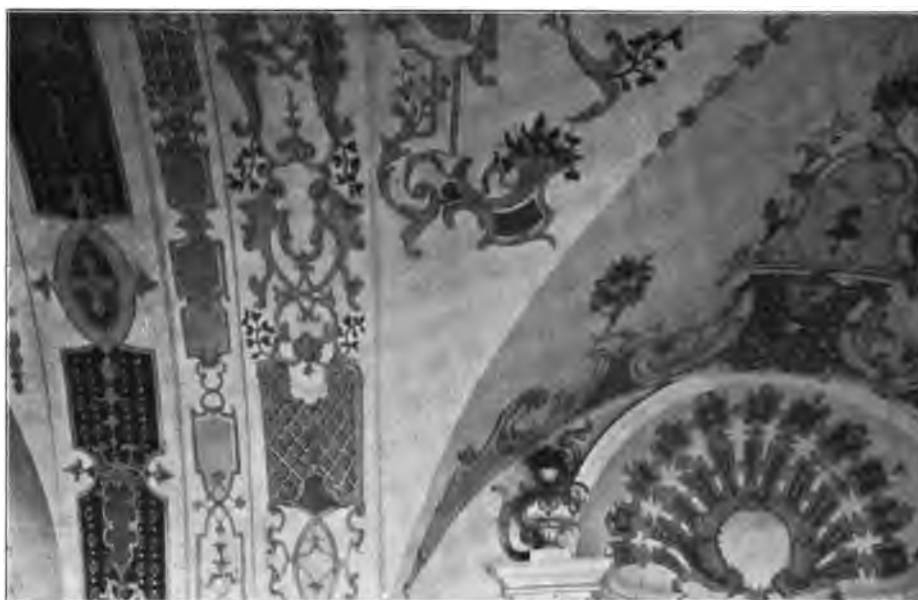
Fig. 98. Reichenbach. Stuckdekoration vom Gewölbe der Vorhalle der Klosterkirche.
